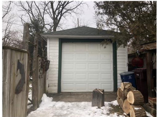
Current Garage Door 1223 Traver Rd.
