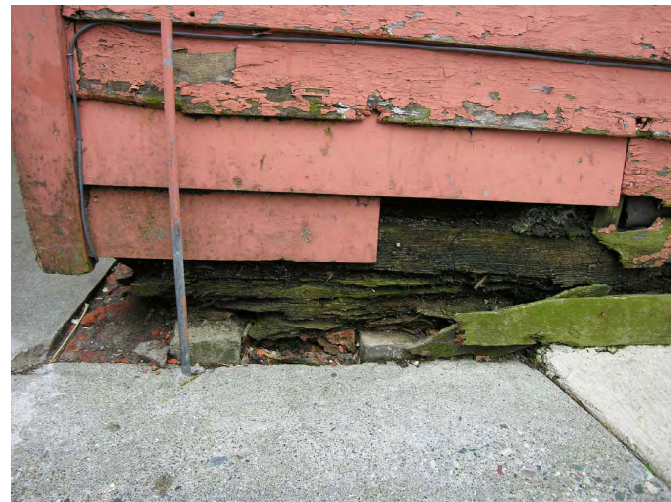
A5 EXISTING FOUNDATION
